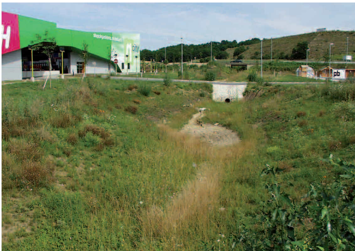
Abb. 22: Extensiv gepflegte Retentionsmulde in Mistelbach
