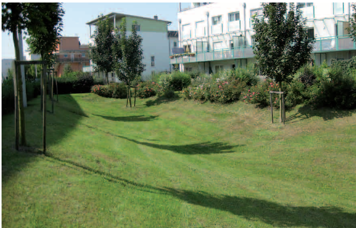
Abb. 20: Intensiv gepflegte Versickerungsmulde in SolarCity Pichling, Linz
